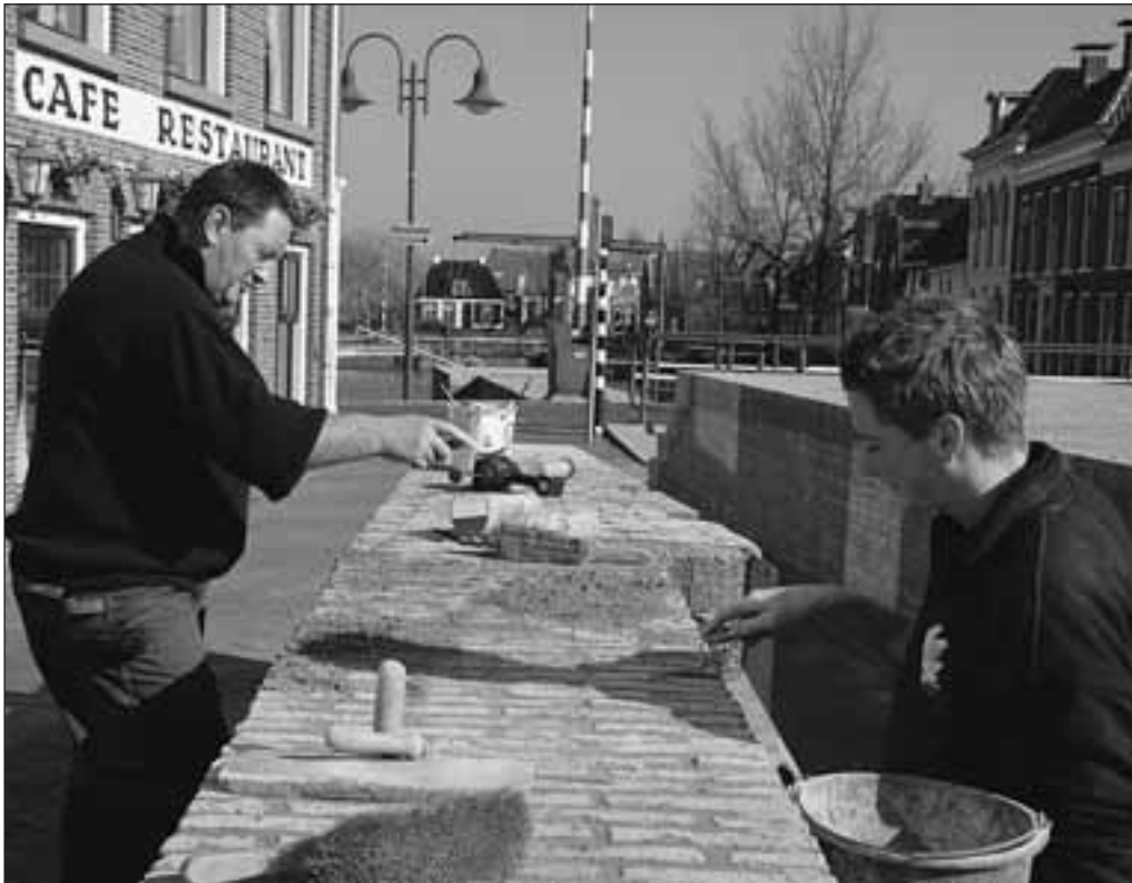
Vorige week schoot de MB fotograaf dit plaatje van het voegwerk aan de klippen ter hoogte van de Leugenbolle. Het werk wordt verricht door Bedrijfsuitvoering Menno Sappe Joure. Op de foto vader en zoon Jan en Eric (rechts) van der Laan uit Noordbergum.
