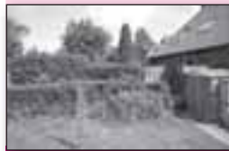
5 Grondsanering in de Slotmakersstraat
